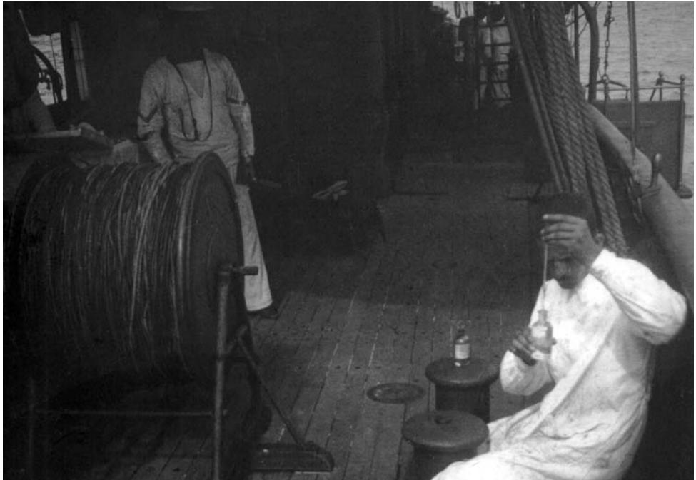
Científic mesurant la salinitat de les mostres d'aigua pel mètode del clorur de plata o mètode de Knüdsen (també podria estar fixant l'oxigen de la mostra amb sulfat de manganès i sosa iodurada o mètode de Winkler)
