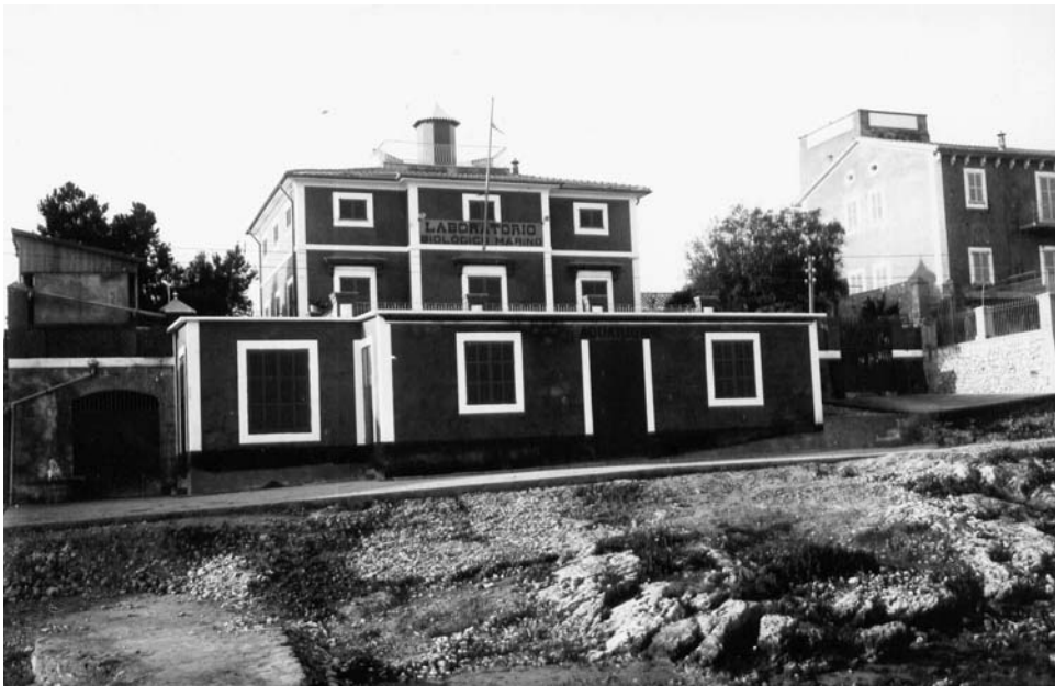
Edifici del Laboratori a Portopí. A la dreta del laboratori apareix també la casa del geòleg Bartomeu Darder.
